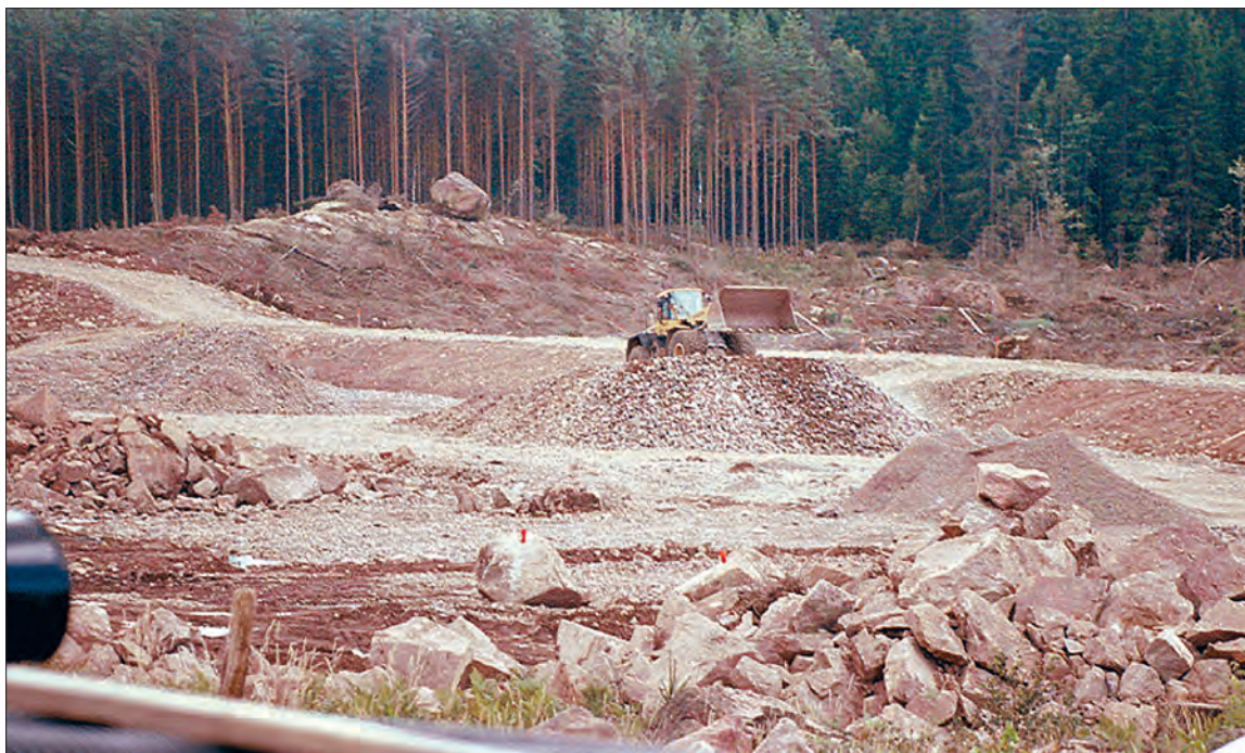
FIGUR 5.8 Schaktning för deponibotten.
