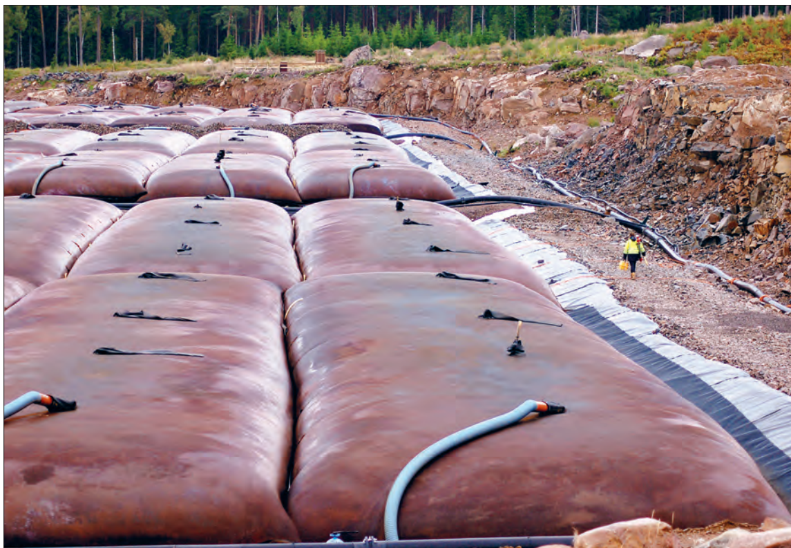
FIGUR 5.6 Avvattning i geotuber.
