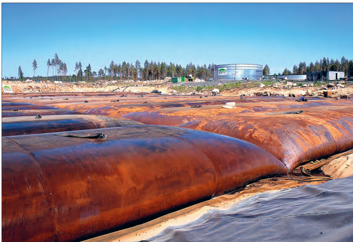
FIGUR 9.4 Geotuber som fyllts med nuddermassor. Vattnet, som rann genom väven, gick till reningsverket i bakgrunden.
