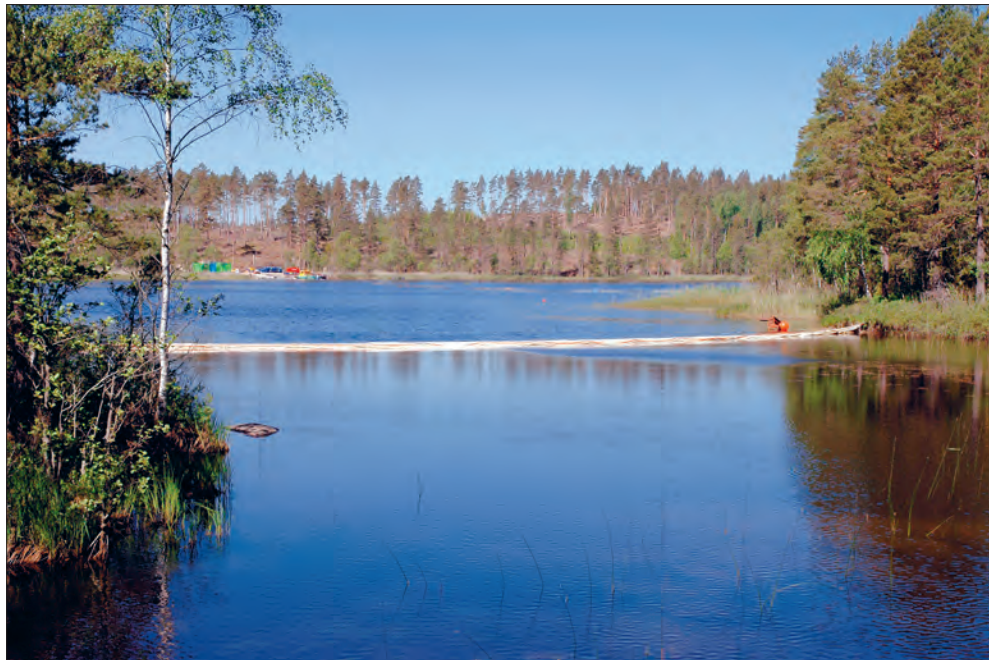
FIGUR 10.1 Under muddringen i Övre Svartsjön spärrades utloppet av med en textilskärm som fångar upp partiklar från muddringen.
