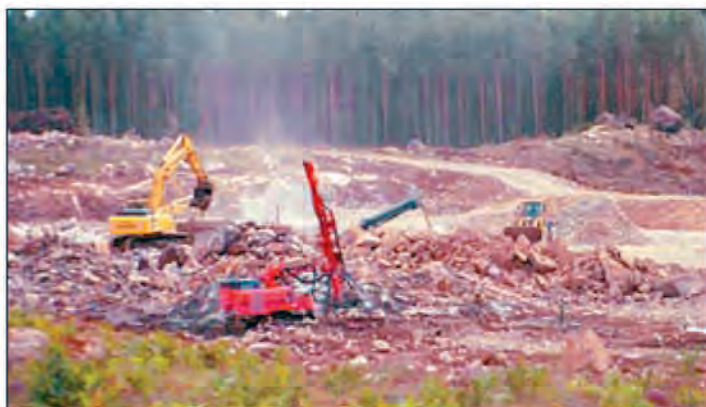
Arbete med att krossa sten på deponibotten vid Övre Svartsjön Foto:Alexandra Zamparas
