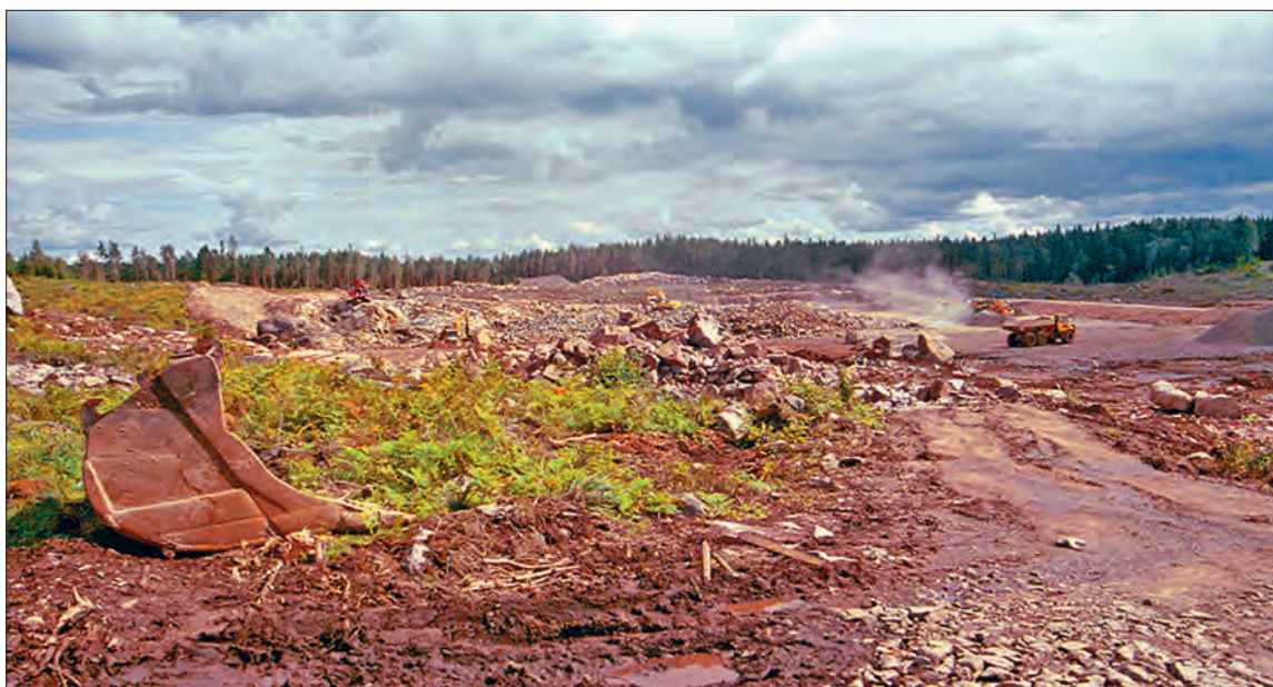
FIGUR 5.1 Anläggande av deponibotten.
