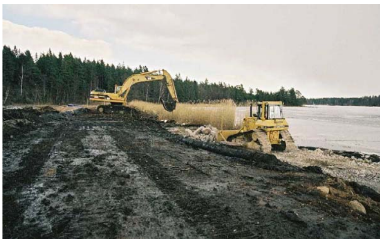
Den nya vallen byggs, våren 2001
