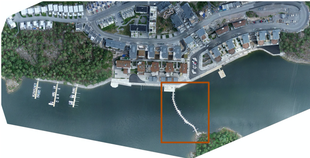
Figur 6. Gångbro till Mårtens holme
