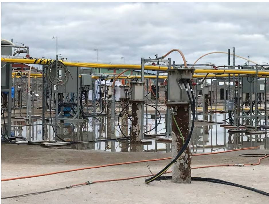
Figur 10 Pågående drift av den termiska behandlingen vid gasverkstomten
