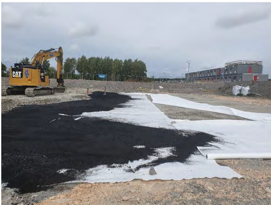
Figur 17 Utläggning av biokol ovanför ytor där den termiska behandlingen utförts.
